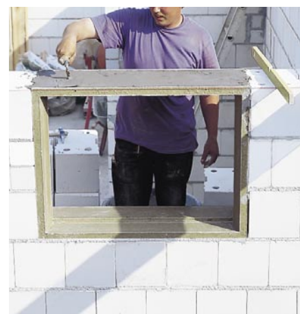
Bild 3/12: Die selbst tragenden Leibungsrahmen werden wie Stürze übermauert.
