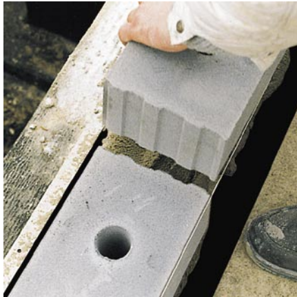
Bild 2/1: Das fachgerechte Aufmauern der Kellerwände beinhaltet auch das Einlegen der Querschnittsabdichtung.
