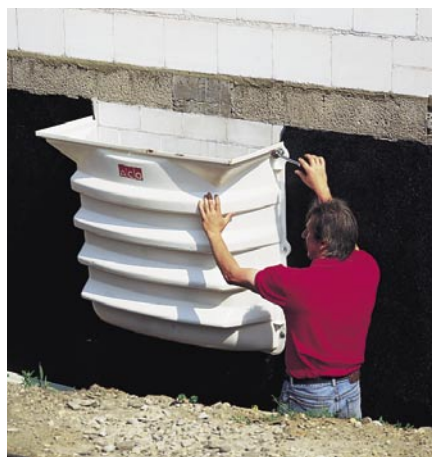
Bild 3/10: Lichtschächte werden meist als Fertigelemente verwendet.
