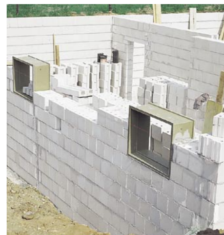
Bild 3/11: Selbst tragende Leibungsrahmen werden mit dem Mauerwerk versetzt.
