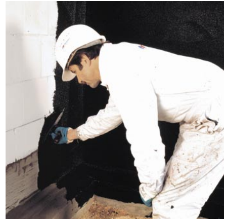
Bild 2/2: Die wasserdichte Abdichtung der Kelleraußenwand erfolgt durch qualifizierte Abdichtungsunternehmen.
