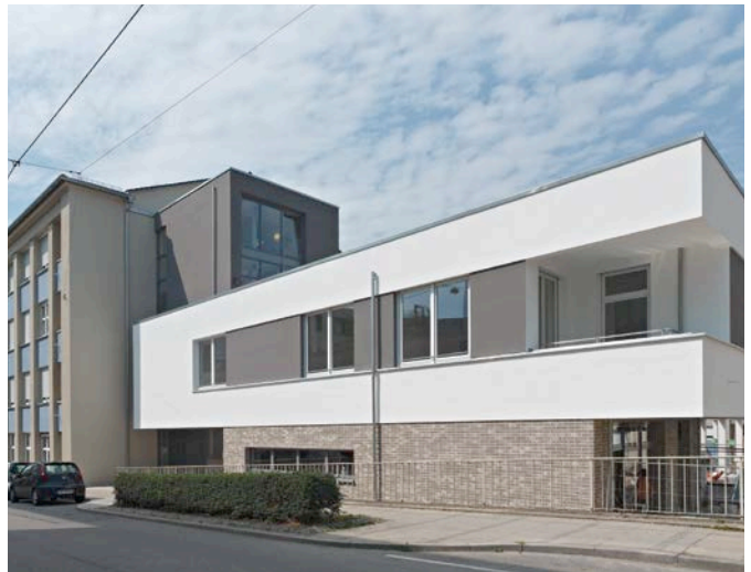
Kalksandstein mit WDVS und Klinkerriemchen im Sockelbereich
