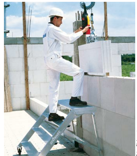
Bild 17: Vermauern von KS XL-Rasterelementen mit Versetzgerät
