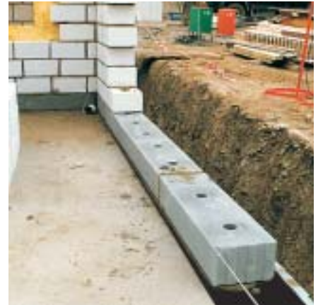
Rohstoffbedingt weisen KS-ISO-Kimmsteine eine graue Färbung auf. Eine Verwechslung mit anderen Kalksandsteinen ist dadurch ausgeschlossen.
