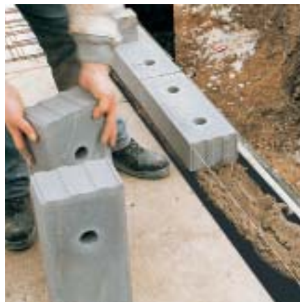
KS-ISO-Kimmsteine werden in Normalmörtel verlegt.
