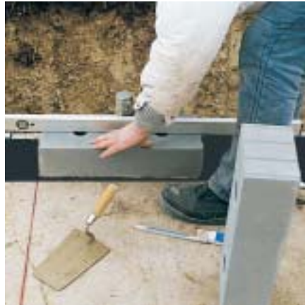
Beim Anlegen der Kimmsschicht werden die KS-ISO-Kimmsteine in Waage gelegt.
