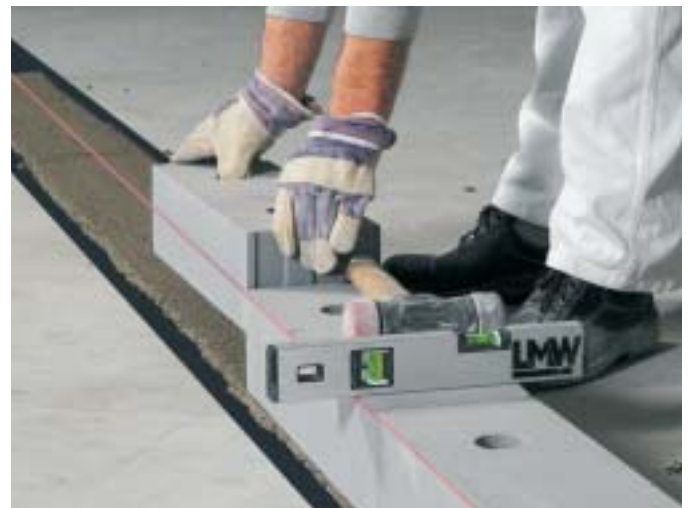
Die Steine werden in Längs- und Querrichtung ausgerichtet.
