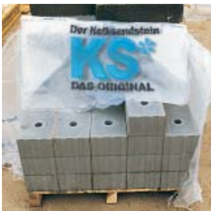
KS-ISO-Kimmsteine sind auf der Baustelle sauber zu lagern und vor übermäßigem Feuchtezutritt zu schützen.
