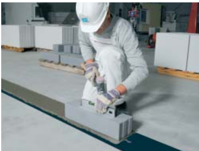
Der erste Stein wird besonders sorgfältig in der Höhe eingemessen.
