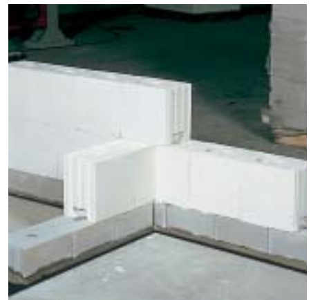
Der KS-ISO-Kimmstein wird zweckmäßigerweise in Außen- und Innenwänden vermauert.
