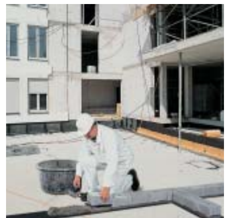
Die Stoßfugen bleiben dabei unvermörtelt.
