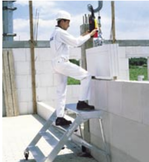
Bild 39: Versetzen von KS XL
