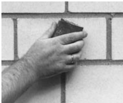
Bild 49: Schonende Reinigung mit Sandpapier, feinste Körnung
