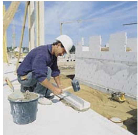
Bild 19: Die Kimmschicht, mit KS-Kimmsteinen einfach anzulegen
