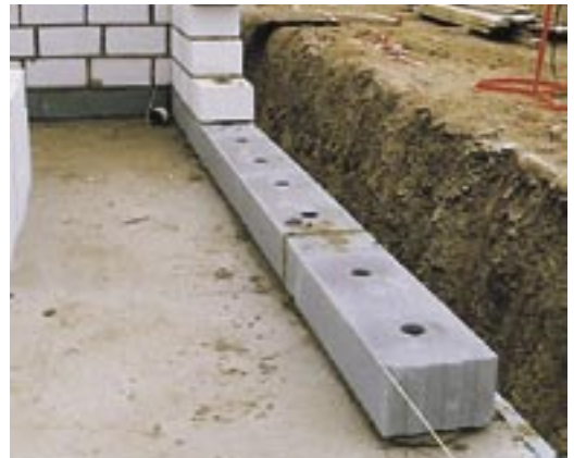
Bild 25: Anlegen der Kimmschicht mit dem KS-ISO-Kimmstein
