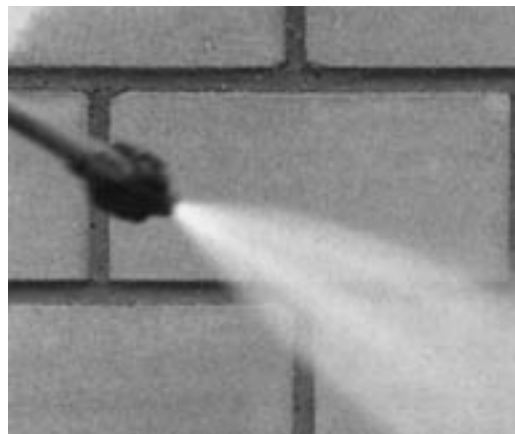
Bild 48: Reinigung mit Dampfstrahlgerät
