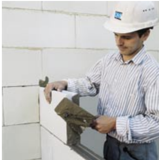
Bild 21: Stumpfstoß einer leichten Trennwand aus KS-Bauplatten
