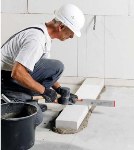
Bild 8 Kimmsteine in Querrichtung ausrichten
