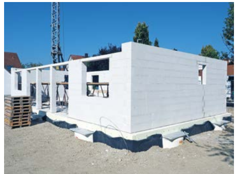
Bild 8 Eine aufgeräumte Baustelle ist die beste Werbung.
