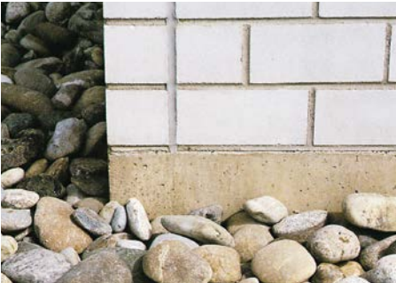
Bild 47 Dehnungsfuge an einer Gebäudeecke mit spritzbarem Dichtstoff
