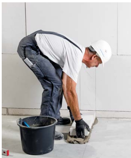
Bild 8 Kimmsteine ins Mörtelbett verlegen
