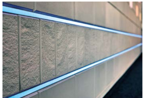
Bild 4 Innensichtmauerwerk aus KS-Fasensteinen kombiniert mit LED-Technik
