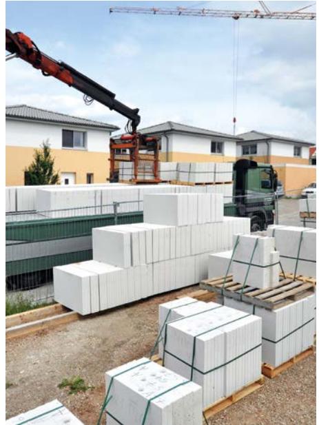
Bild 14 Der Transport auf der Baustelle mit dem Baustellenkran sowie geeigneten Steinkörben ist leicht und sicher.
