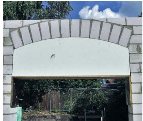
Bild 23 Ausführung eines Flachbogens auf einer Holzschablone
