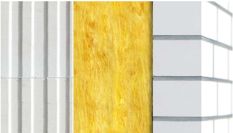
Bild 2 Zweischaliger Wandaufbau mit Hintermauerung, Dämmung und Verblendung
