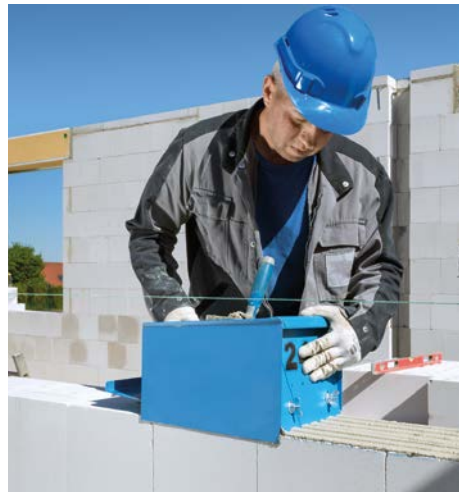
Bild 7 Der Auftrag mit dem Mörtelschlitten und der passenden Zahnschleife führt zu einem gleichmäßigen Mörtelauftrag.
