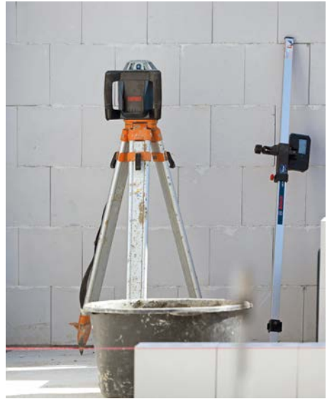
Bild 2 Das Schichtmaß wird mit Hilfe eines Hochbaulasers angezeichnet.
