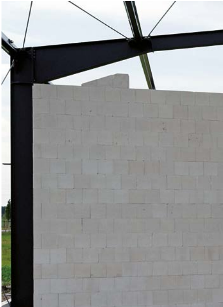
Bild 24 Kalksandstein-Mauerwerk als Ausfachung einer Stahlkonstruktion
