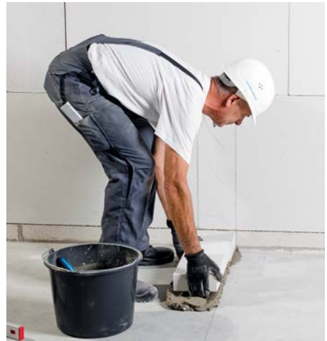
Bild 7 Kimmstein ins Mörtelbett verlegen
