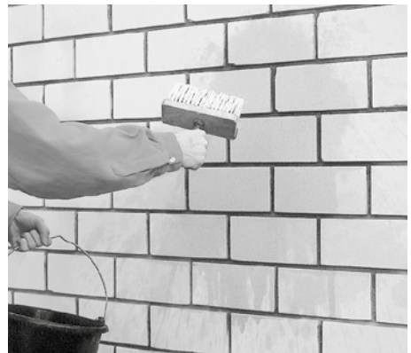
Bild 32 Das Fugennetz ist gründlich vorzunässen, um das „Verdursten“ des Fugenmörtels zu vermeiden.
