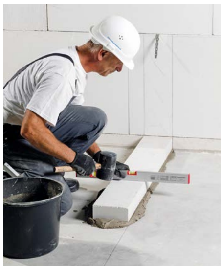
Bild 9 Kimmsteine in Querrichtung ausrichten
