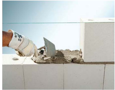
Bild 4 Verarbeitung von Normalmauermörtel
