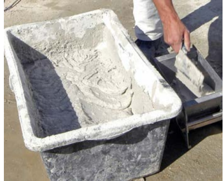
Bild 5 Der Dünnbettmörtel wird in den Mörtelschlitten eingefüllt.
