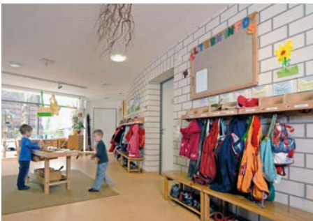
Bild 3 Innensichtmauerwerk aus KS-Verblendern
