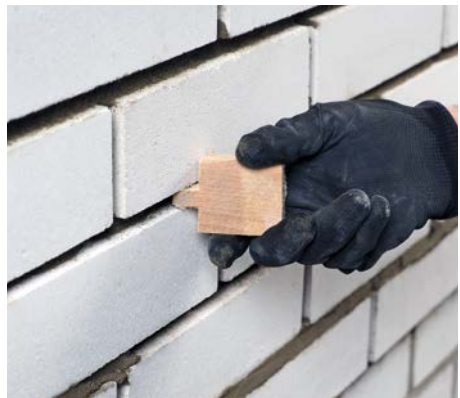
Bild 29 Auskratzen der Fugen mit einem Holzbrettchen
