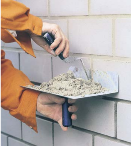
Bild 33 Der Fugenmörtel wird fest in die Fugen gedrückt.
