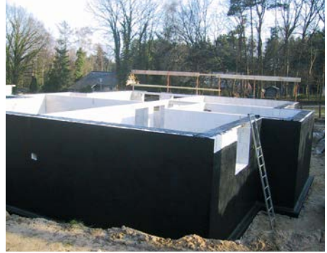
Bild 3 Kellerwand-Außenseite mit PMBC-Abdichtung
