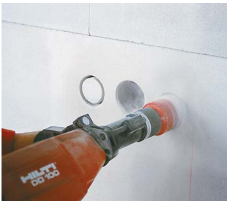
Bild 5 Fräsen von Öffnungen für Schalterdosen
