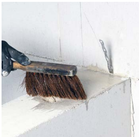
Bild 28 Bei starker Hitze ist das Vornässen der Mauersteine notwendig.
