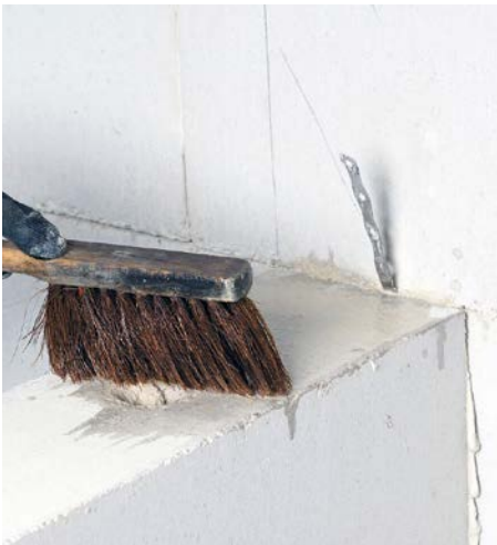
Bild 6 Bei hohen Außentemperaturen sind die Steine vorzunässen.
