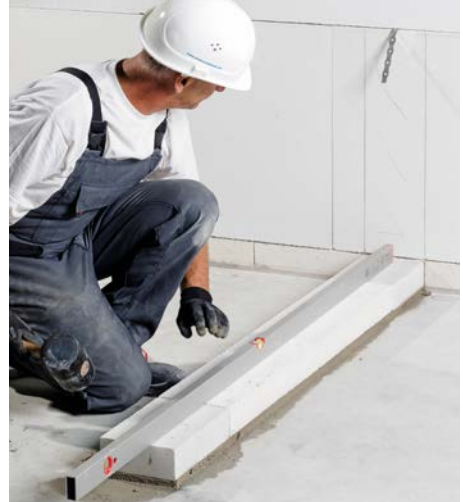
Bild 9 Kimmsteine in Längsrichtung ausrichten
