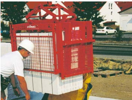
Bild 7 Absetzen der Steinpakete mit dem Baustellenkran auf der Zwischendecke
