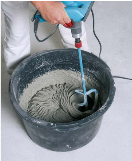
Bild 14 Der Mörtel wird nach Verarbeitungsanweisung gleichmäßig durchgemischt.
