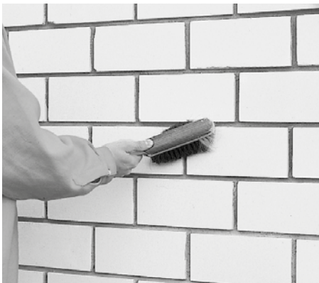
Bild 31 Eventuell vorhandene Mörtelreste sind abzufegen.
