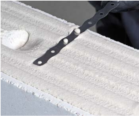
Bild 51 Beim Aufmauern wird der Edelstahl-Flachanker im Mörtelbett eingelegt.
