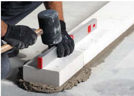
Bild 2 Kontrolle der Ebenheit in Wandlängsrichtung
