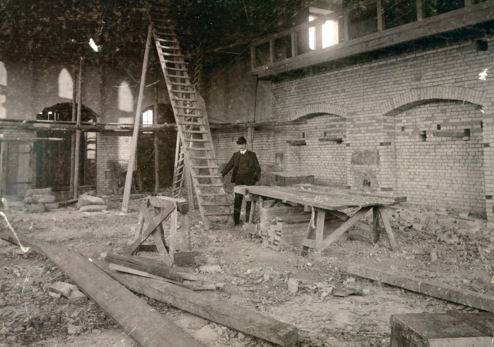
Baustellenimpression um 1909: Das Gymnasium Dionysianum im noch „fensterlosen“ Rohbau.
